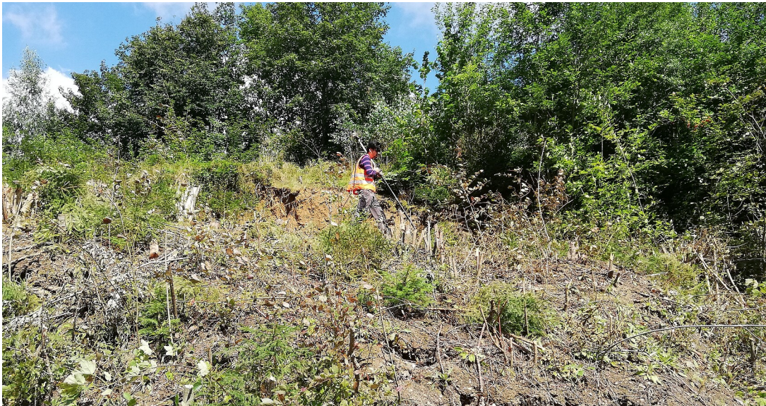
Vermessungsaufnahmen im Bereich der abgerutschten Böschung
