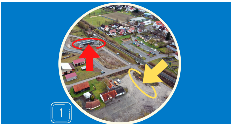
Baustelle B 28 bei Kiebingen
