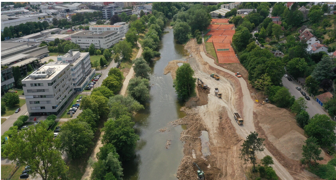
Luftaufnahme von den Baumaßnahmen am Flusspark Neckaraue in Tübingen
