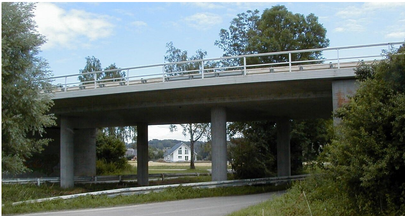
Lonebrücke in Breitingen
