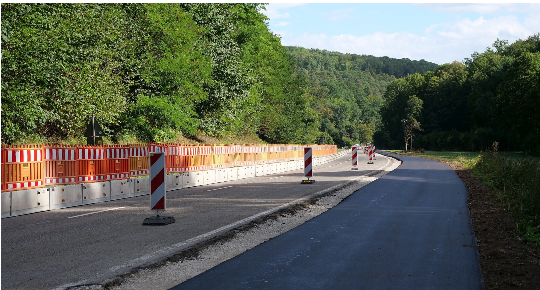
L 1208 Ausbau zwischen Lustnau und Bebenhausen
