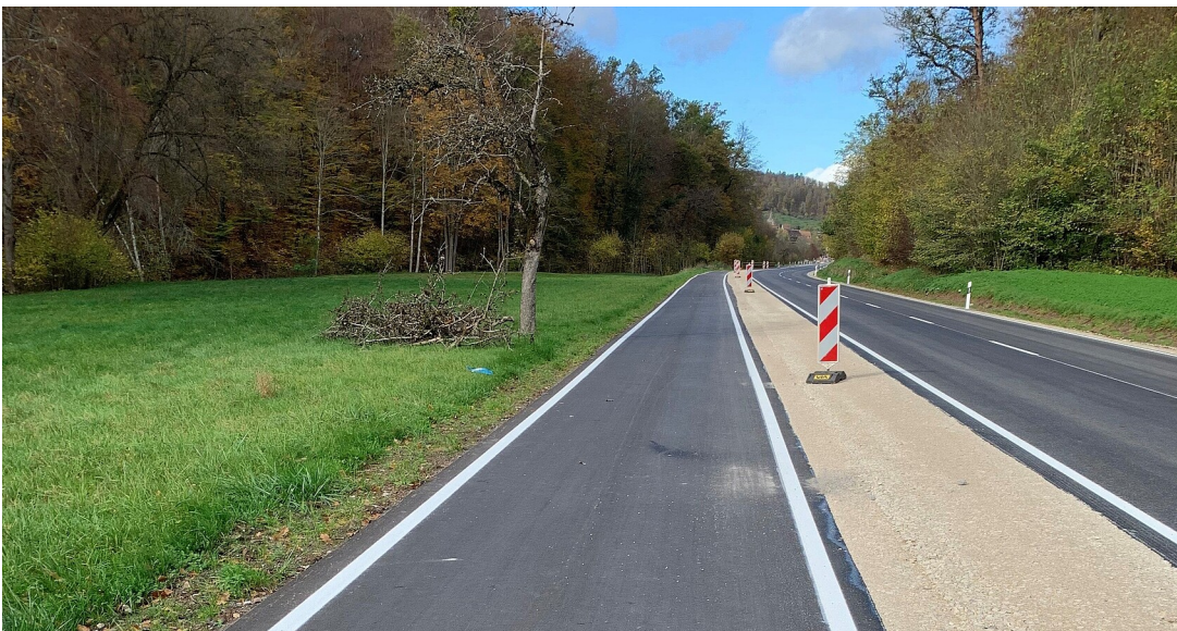
L 1208 Ausbau zwischen Lustnau und Bebenhausen
