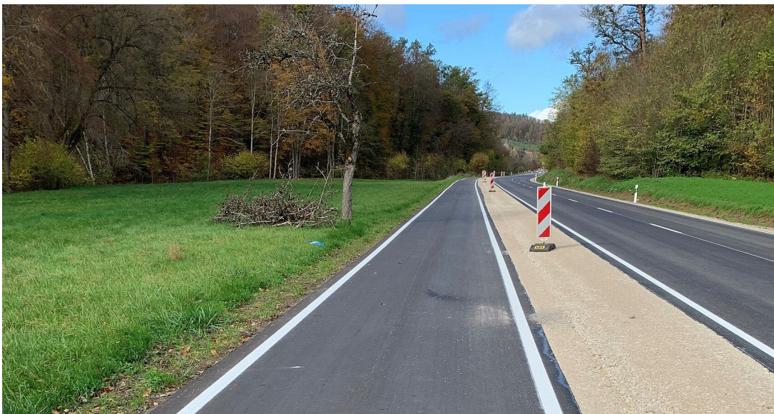
L 1208 Ausbau zwischen Lustnau und Bebenhausen
