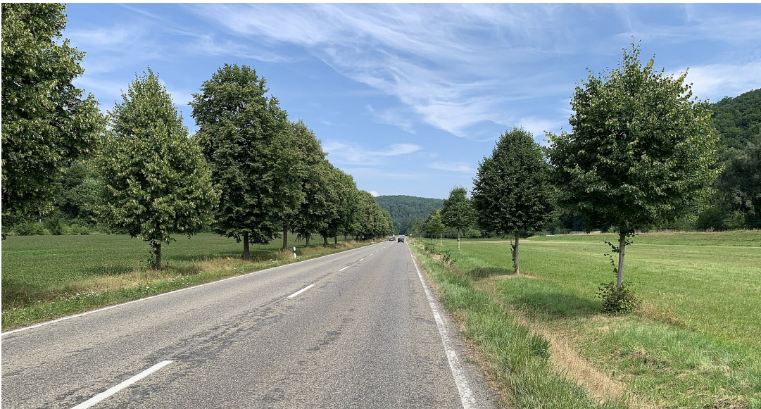
Landesstraße 1208 zwischen Tübingen-Lustnau und Tübingen Bebenhausen
