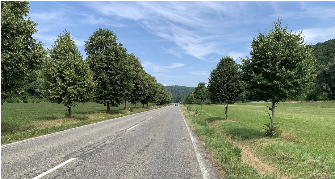
Landesstraße 1208 zwischen Tübingen-Lustnau und Tübingen Bebenhausen
