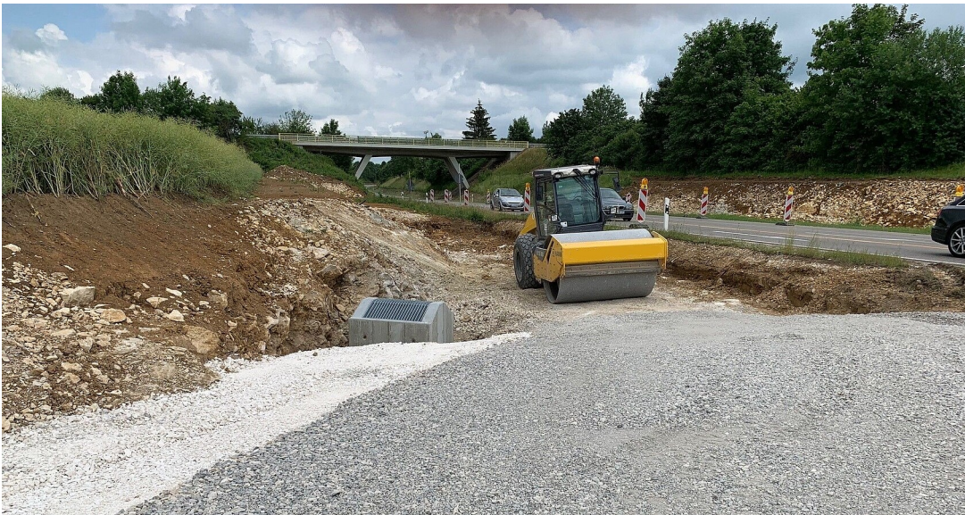
Bauarbeiten an der L 1230 bei Merklingen
