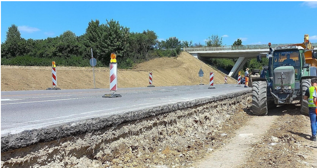
Verbreiterung L 1230 für Ein- und Ausfädelstreifen, Blickrichtung Nord
