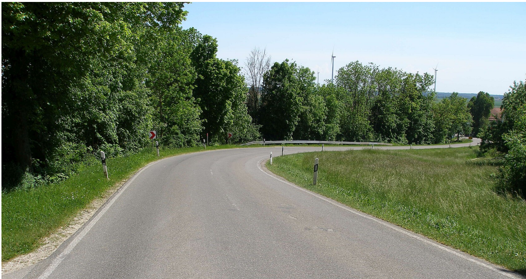
Landesstraße 1233 zwischen Scharenstetten und Temmenhausen
