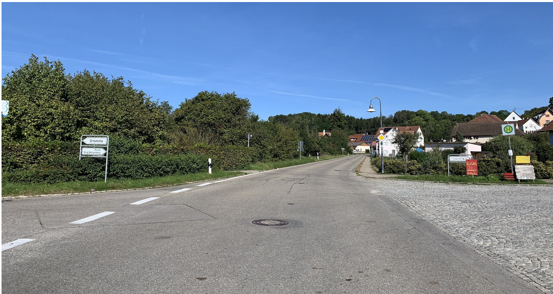
Die L196 zwischen Rohrdorf und Kreenheinstetten vor Beginn der Baumaßnahme
