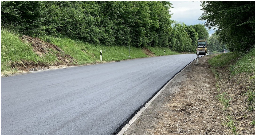
Symbolbild für eine Straßensanierung
