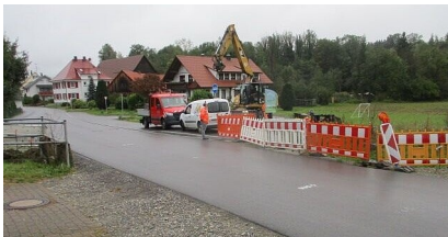
Schupelbachdurchlass am östlichen Ortseingang Urnau
