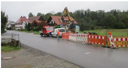
Schupelbachdurchlass am östlichen Ortseingang Urnau
