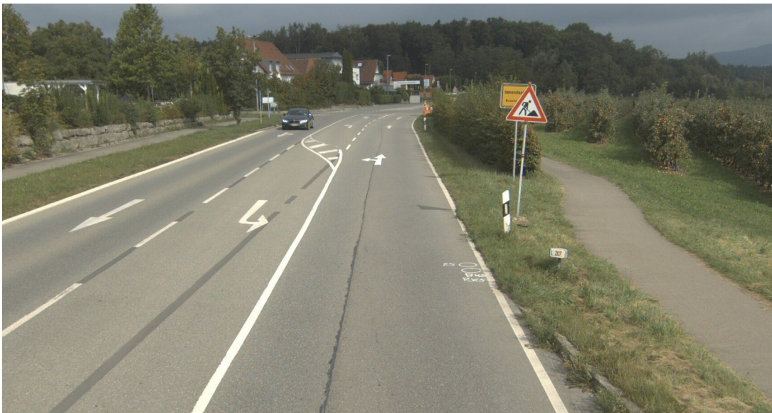
L 207 in Immenstaad Siedlung
