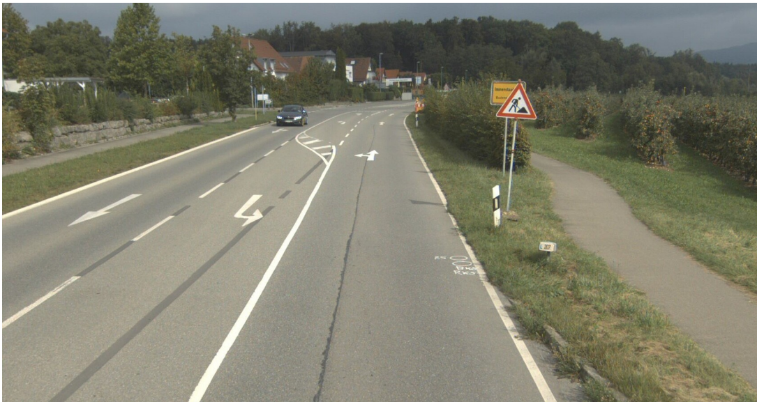
L 207 in Immenstaad Siedlung
