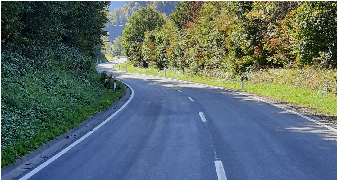
L 211 zwischen Bad Urach und Grabenstetten
