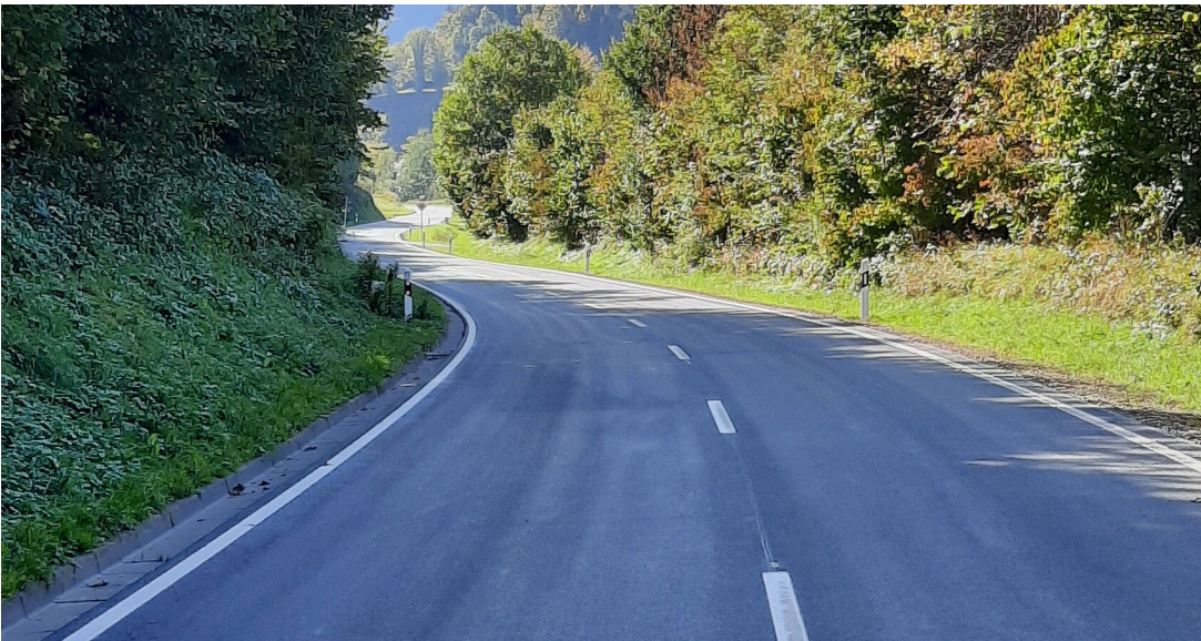
L 211 zwischen Bad Urach und Grabenstetten
