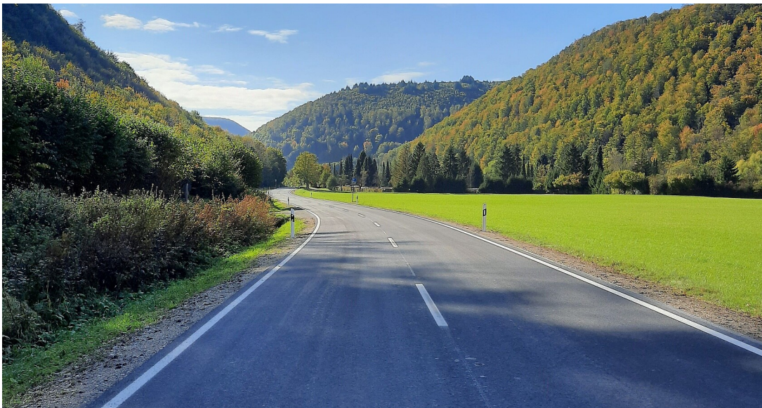
L 211 zwischen Bad Urach und Grabenstetten nach der Sanierung
