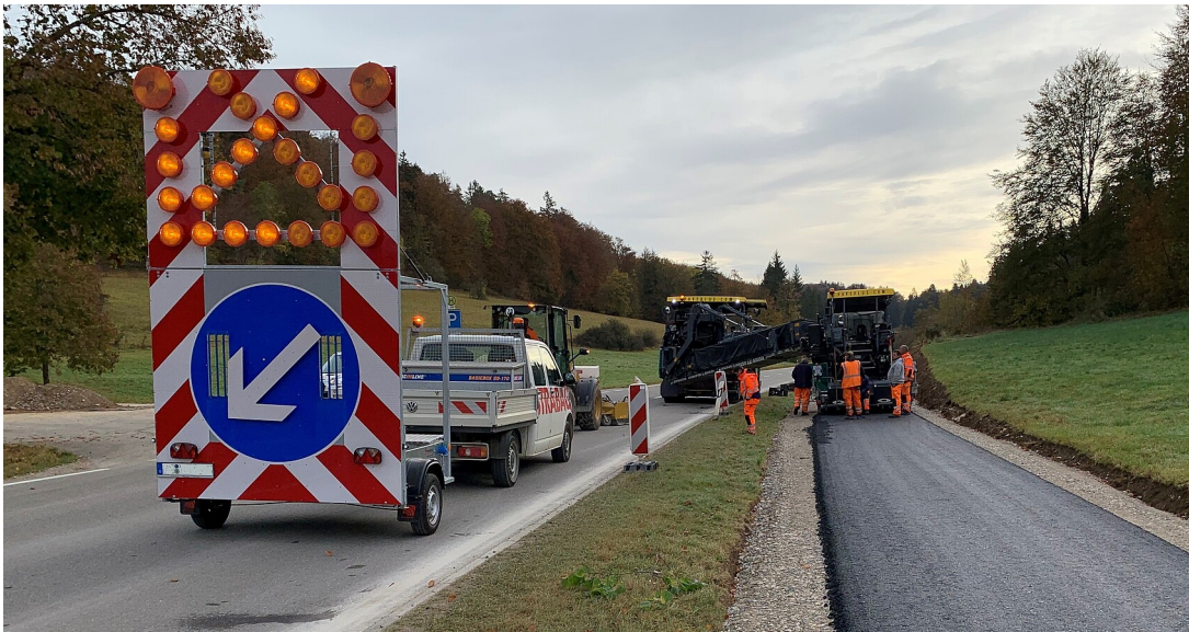
Bau des Rad- und Wirtschaftsweges von Sonnenbühl-Genkingen bis zur Zufahrt zum Schloss Lichtenstein
