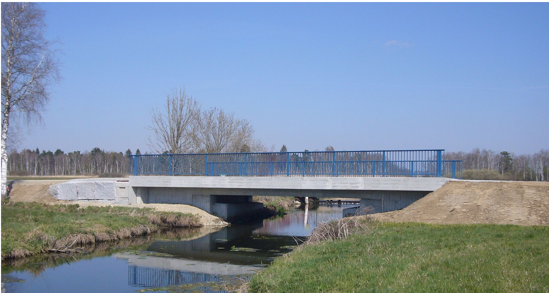
Ersatzneubau der Brücke über die Kanzach
