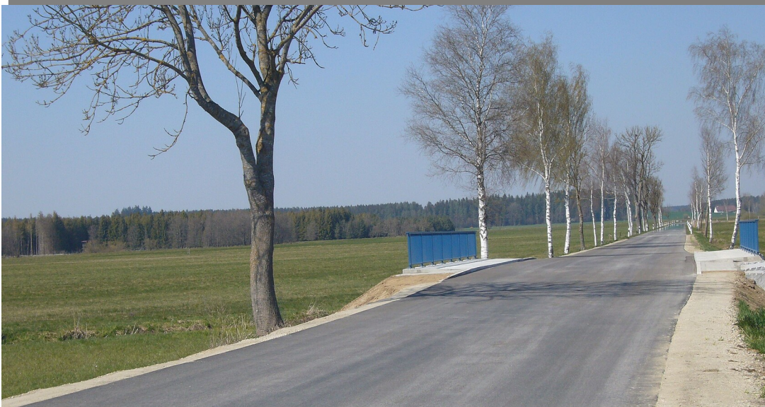
Ersatzneubau der Brücke über die Kanzach
