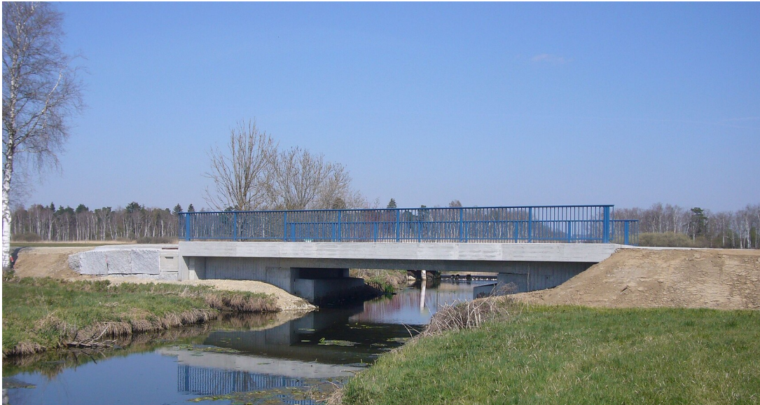
Ersatzneubau der Brücke über die Kanzach
