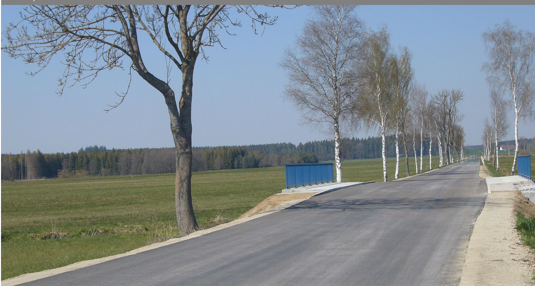
Ersatzneubau der Brücke über die Kanzach
