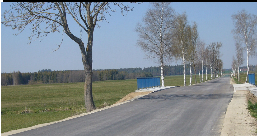
Ersatzneubau der Brücke über die Kanzach
