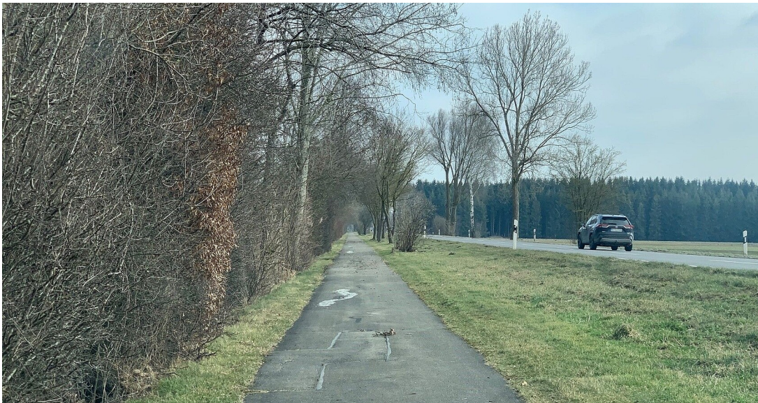
Landesstraße 275 zwischen Vollochhof und Bad Buchau
