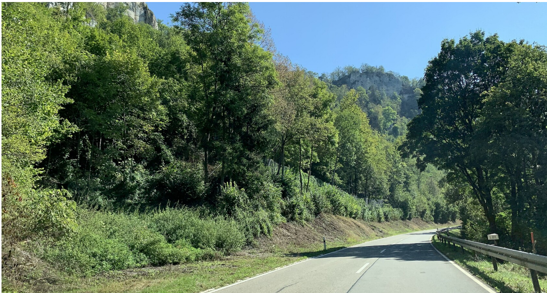
Felssicherungsarbeiten bei Beuron
