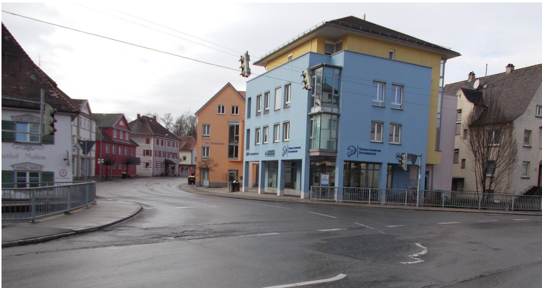
Mohrenbrücke über die Eschach in Leutkirch im Allgäu
