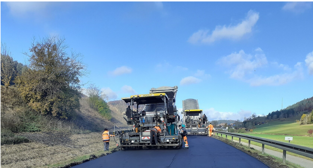
Symbolbild für eine Straßensanierung
