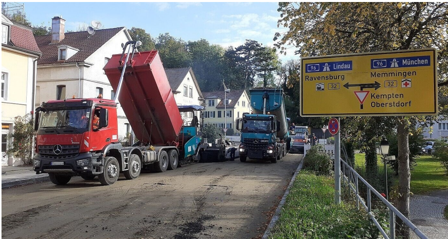
Sanierung der L 320 in der Ortsdurchfahrt von Wangen
