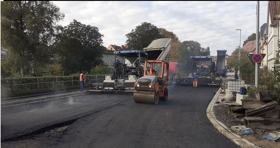
Sanierung der L 320 in der Ortsdurchfahrt von Wangen
