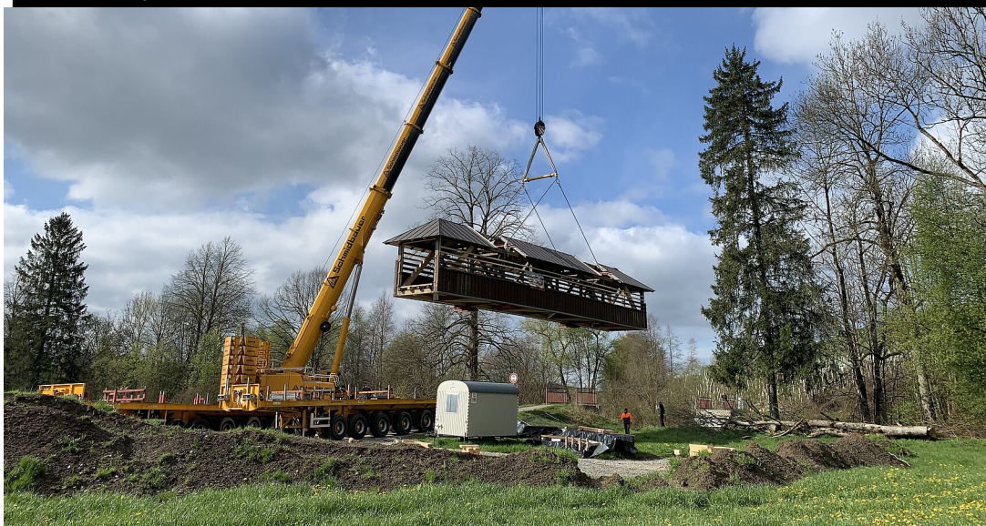
Instandsetzung der Radwegbrücke bei Wangen-Jussenweiler
