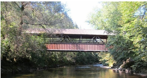
Brückenbauwerk über die Obere Argen
