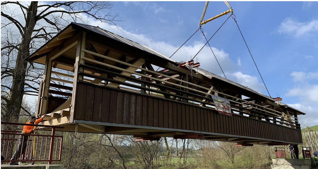
Archivfoto von den Instandsetzungsarbeiten der Radwegbrücke bei Wangen-Jussenweiler
