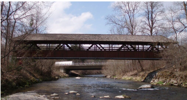
Radwegbrücke über die Untere Argen bei Kißlegg-Dürren
