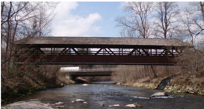
Radwegbrücke über die Untere Argen bei Kißlegg-Dürren
