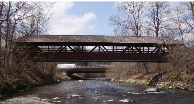
Radwegbrücke über die Untere Argen bei Kißlegg-Dürren
