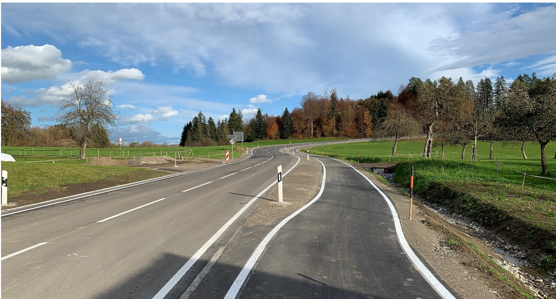
L 333 zwischen Pflegelberg und Primisweiler
