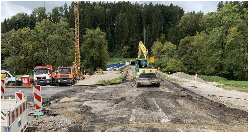
Abgefräste L 333 im Bauabschnitt II mit in Bau befindlicher Radwegbrücke
