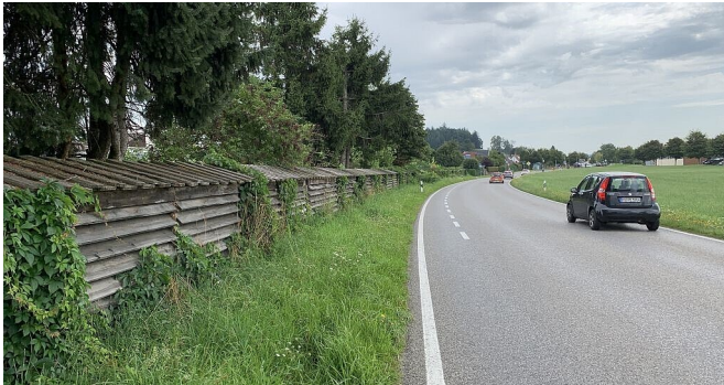
Lärmschutzwand in Primisweiler im Zuge der L 333
