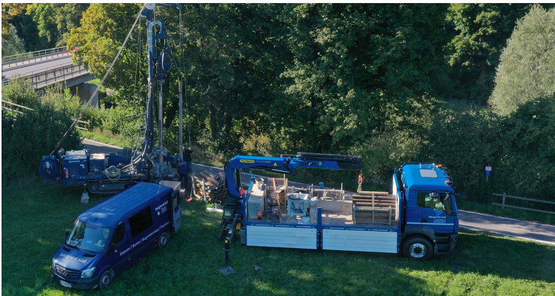
Symbolbild für eine Baugrunderkundung
