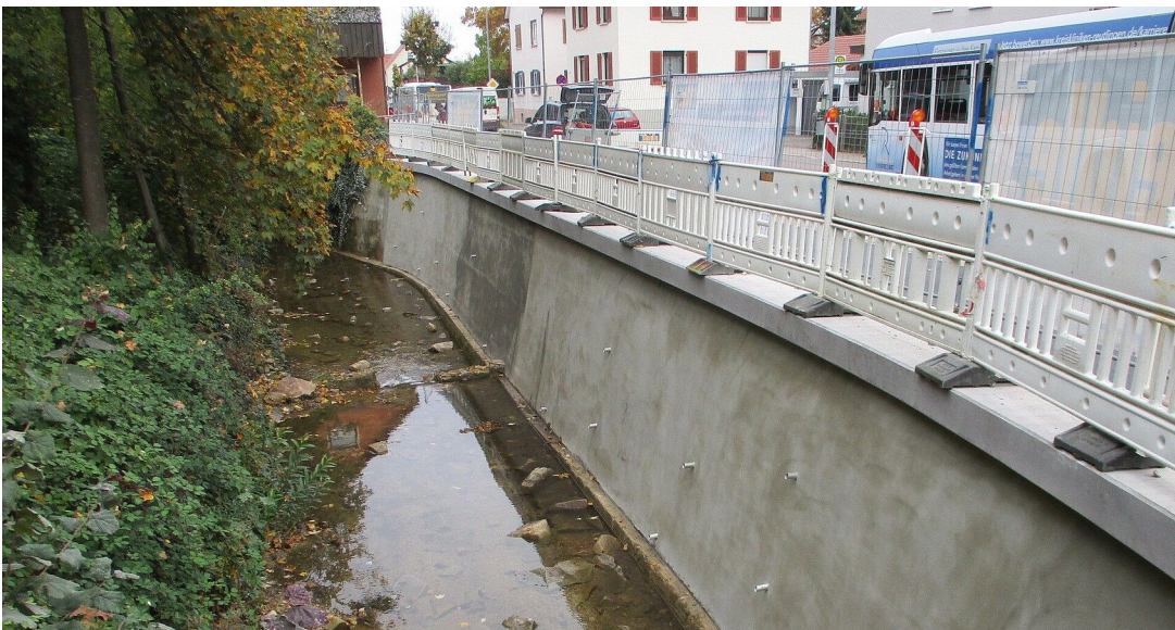
Stützwand entlang der L 382 in Pfullingen
