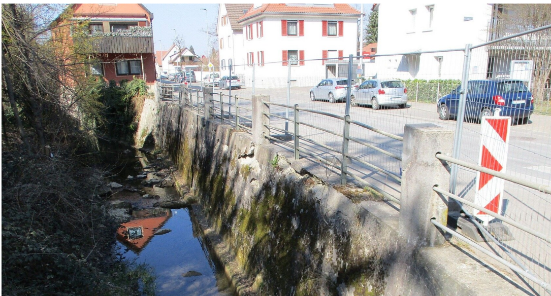
Stützwand entlang der L 382 in Pfullingen
