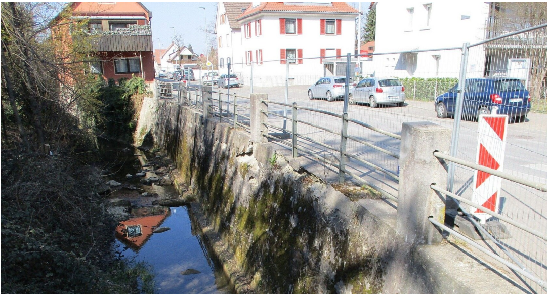
Stützwand entlang der L 382 in Pfullingen
