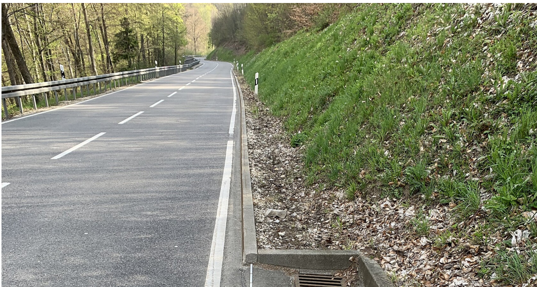
Standort der zukünftigen Betonschutzwand an der Talheimer Steige
