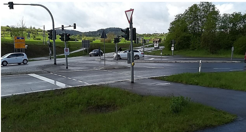
Ampelanlage an der L 385 / L370 Einmündung Tübinger Straße in Rottenburg am Neckar
