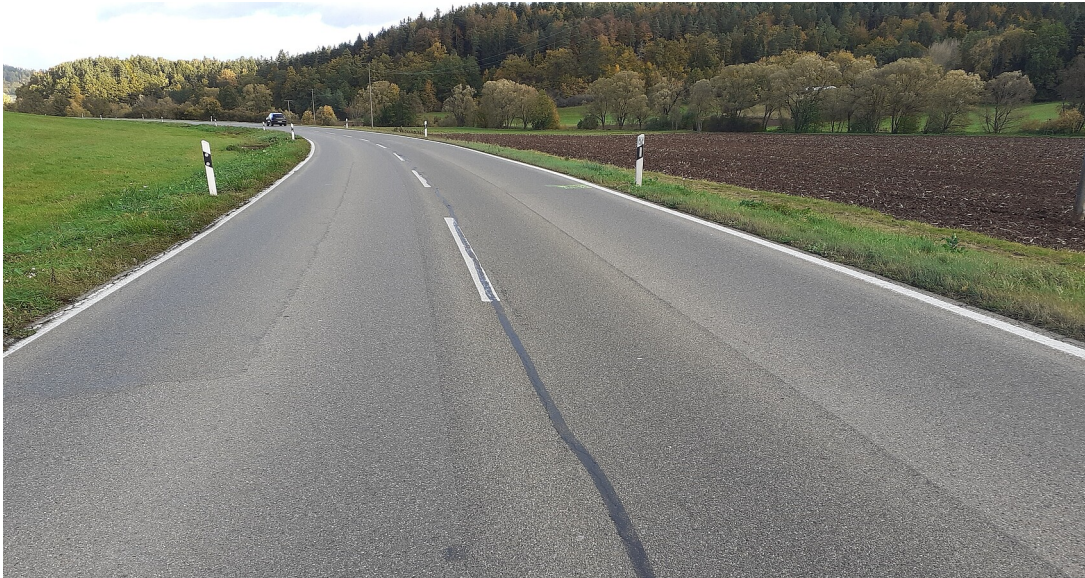
L 390 zwischen Rosenfeld-Heiligenzimmern, Einmündung Fabrikle bis Anschluss L 415
