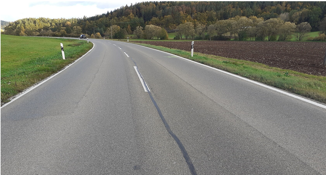
L 390 zwischen Rosenfeld-Heiligenzimmern, Einmündung Fabrikle bis Anschluss L 415
