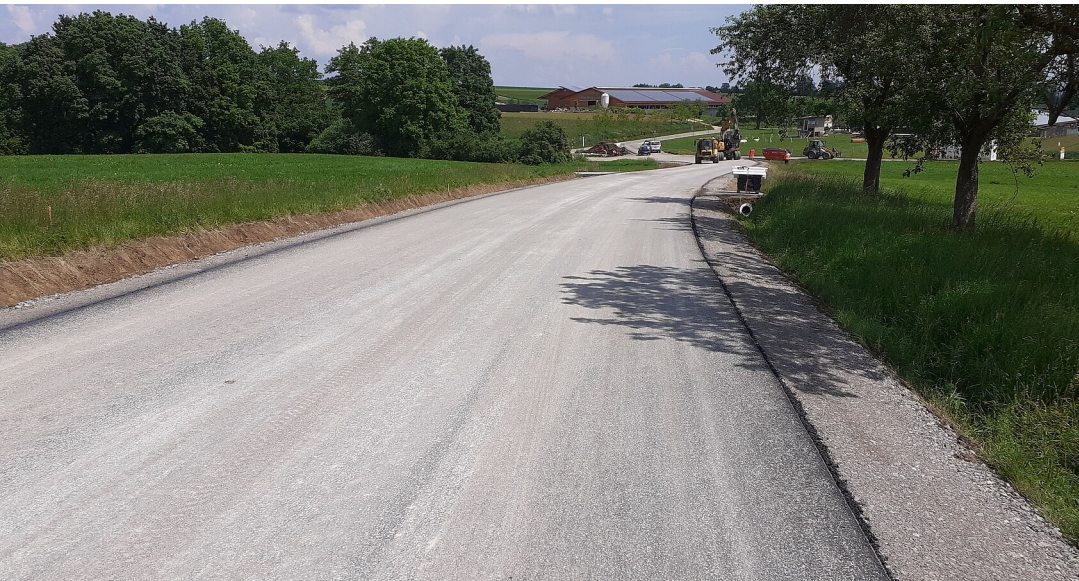
Sanierung der L 391 zwischen Grosselfingen und Rangendingen
