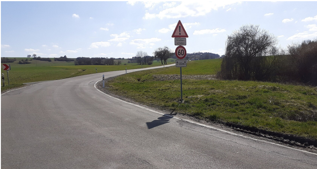
Landesstraße L 391 zwischen Grosselfingen und Rangendingen
