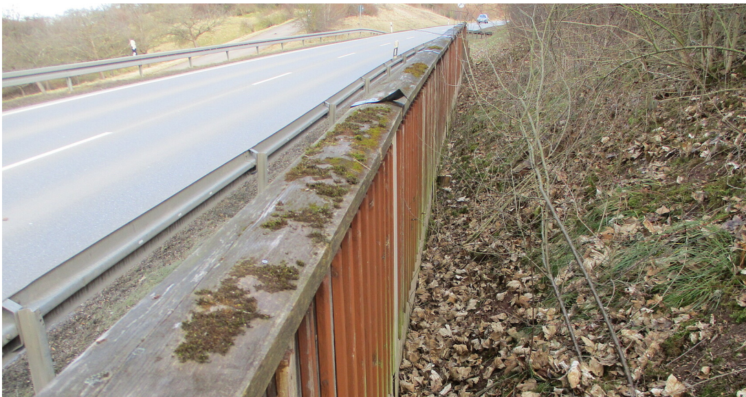
L 410, Instandsetzung der Lärmschutzwand bei Hechingen-Stein
