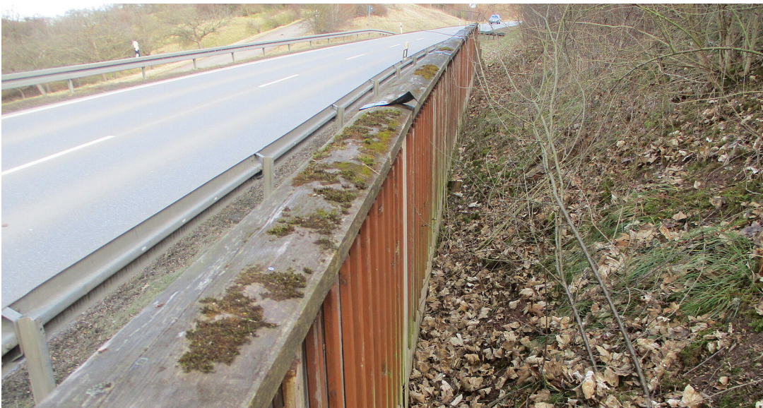
L 410, Instandsetzung der Lärmschutzwand bei Hechingen-Stein
