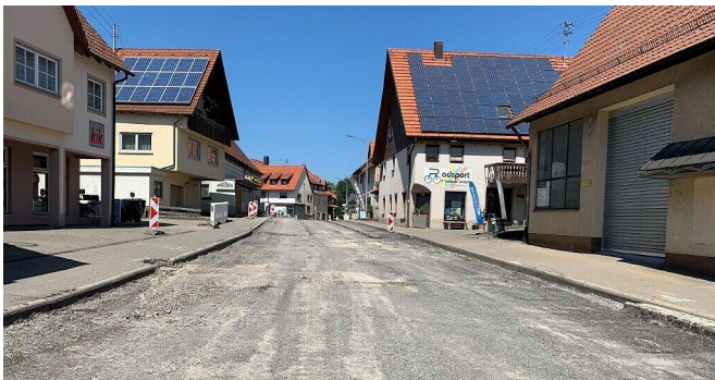
Fahrbahndeckenerneuerung in der Ortsdurchfahrt von Geislingen im Verlauf der L 415
