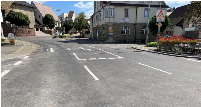
Sanierte Ortsdurchfahrt von Geislingen im Zuge der L415
