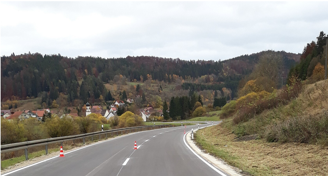
L 440 zwischen Unterdigisheim und Oberdigisheim
