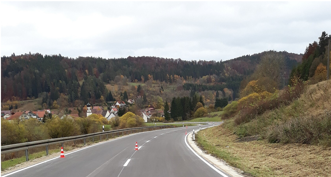
L 440 zwischen Unterdigisheim und Oberdigisheim
