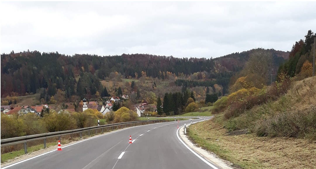
L 440 zwischen Unterdigisheim und Oberdigisheim
