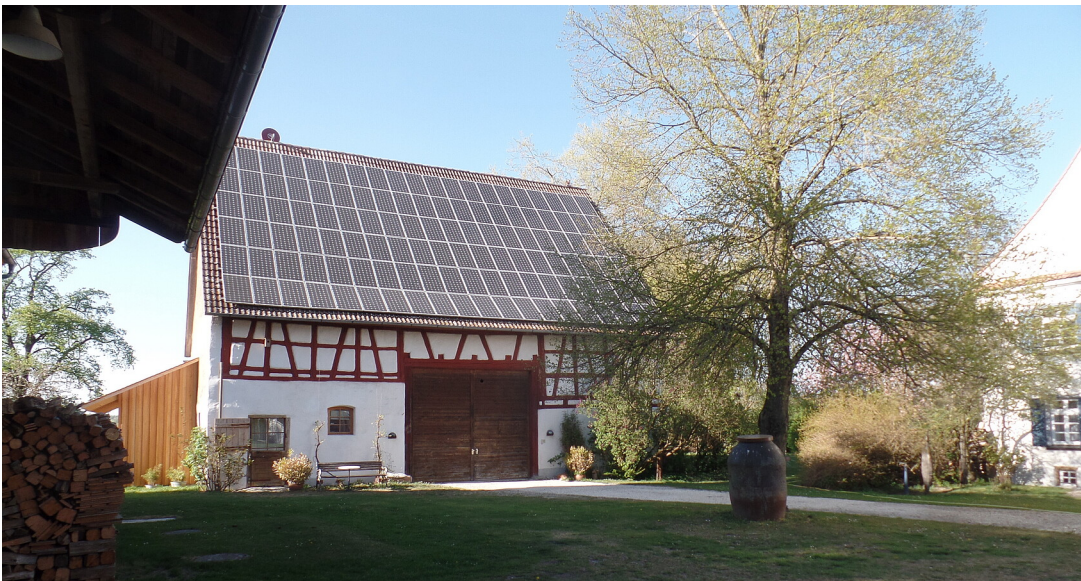
Habsthal_Eimühle - Einbau von Wohnungen in einem ehemaligen Scheunengebäude
