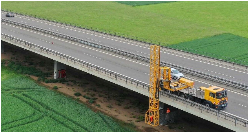
Brückenuntersichtgerät während der Arbeit
