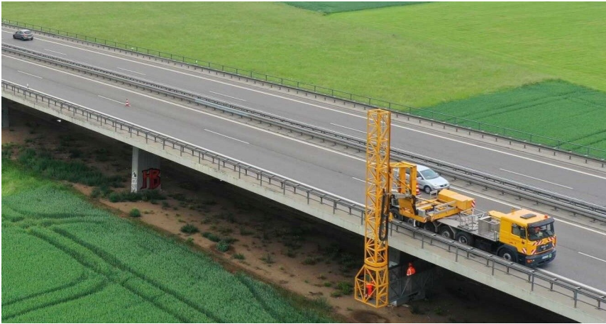
Brückenuntersichtgerät während der Arbeit
