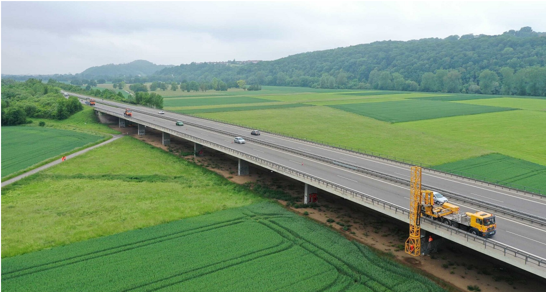
Brückenuntersichtgerät während der Arbeit
