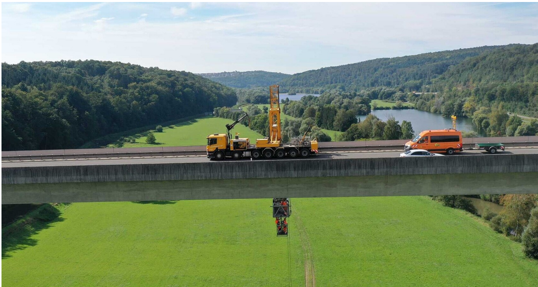
Brückenuntersichtgerät im Einsatz
