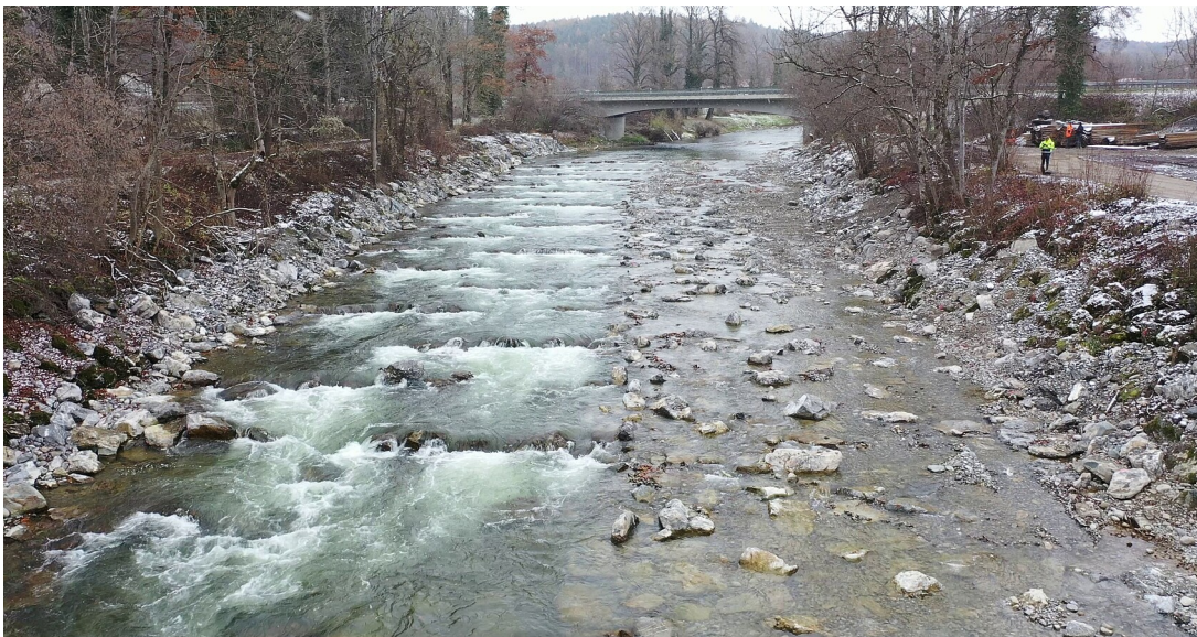
Die zweigeteilte Raue Rampe bei Niedrigwasser
