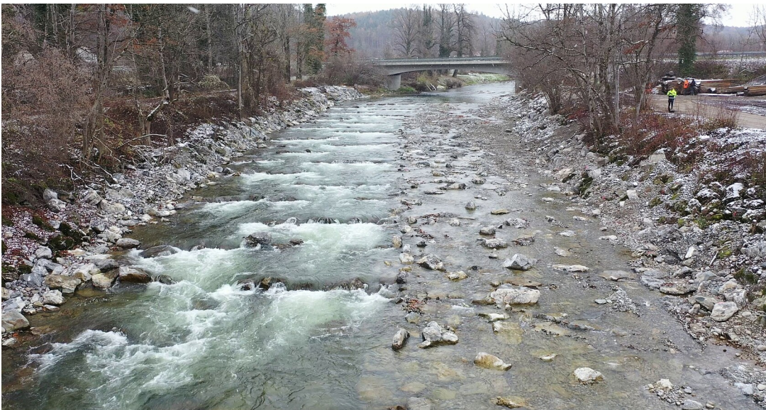
Die zweigeteilte Raue Rampe bei Niedrigwasser
