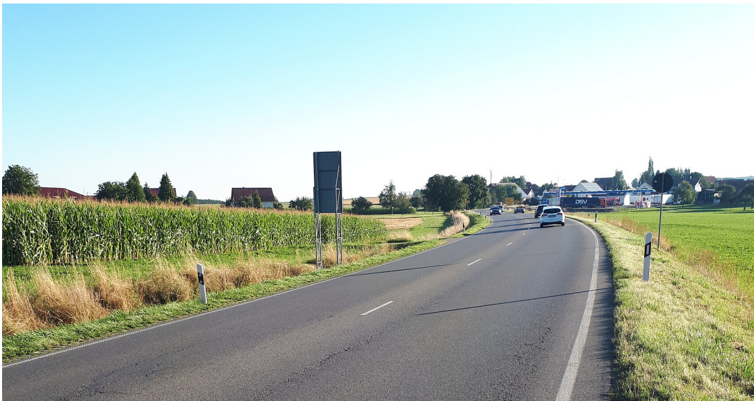
B 30 Fahrbahndeckenerneuerung zwischen Egelsee und Gaisbeuren
