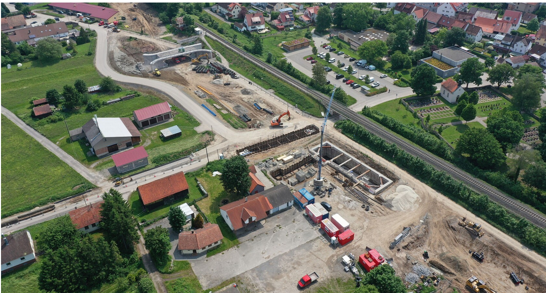
B 28 zwischen Rottenburg und Tübingen
